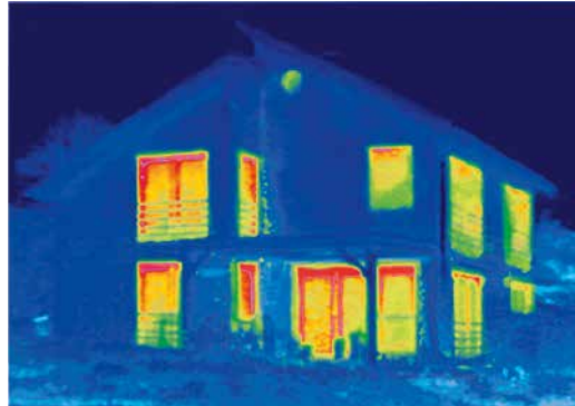
Infrarotaufnahmen, Thermografien, zeigen deutlich, wo ein Haus unkontrolliert Energie verliert. Rot bedeutet Wärme und damit hohen Energieverlust.
